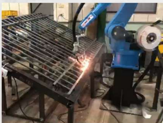
• 鍍鋅鋁管欄杆焊接
